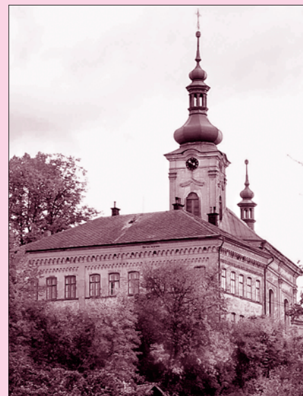
BÝVALÁ ZÁLOŽNA S KOSTELEM SV. BARTOLOMĚJE – dominanta městské památkové zóny – čeká podobně jako řada zdejších dalších objektů na svoji rekonstrukci
